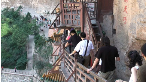
狭い通路、狭い空間には大小 40 室
