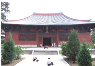
間口7間大きな寄棟の大雄宝殿
