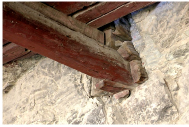
深く穴を彫り梁は楔で止めて有る。
