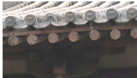
背割りした丸太の垂木に本葺き瓦に家紋。 山中の田舎にひっそりと。
